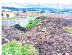
CONSTRUCCION DE MURO
